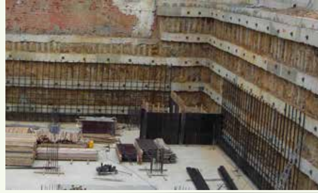
» Fore Kazık Uygulaması
