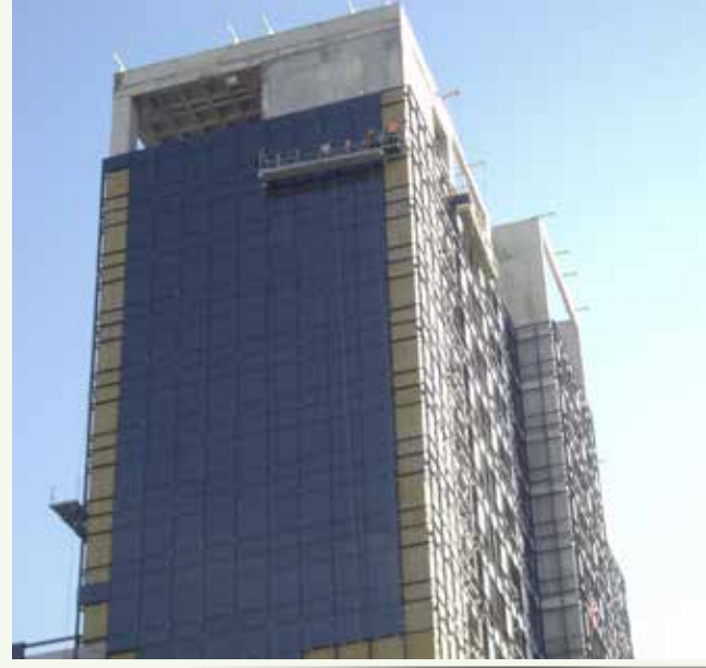
» Dış Cephe Yalıtımı
