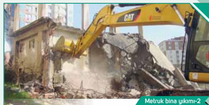
Metruk bina yıkımı-2
