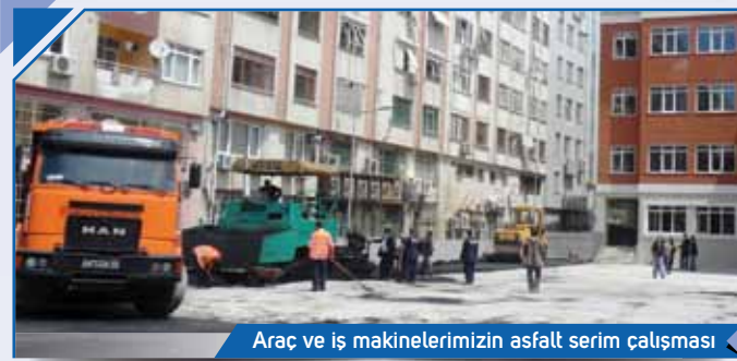
Araç ve iş makinelerimizin asfalt serim çalışması
