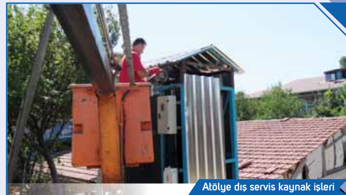
Atölye dış servis kaynak işleri
