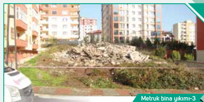
Metruk bina yıkımı-3
