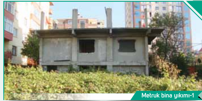
Metruk bina yıkımı-1
