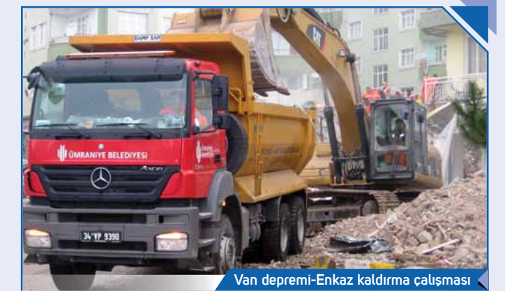
Van depremi-Enkaz kaldırma çalışması
