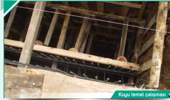
Kuyu temel çalışması
