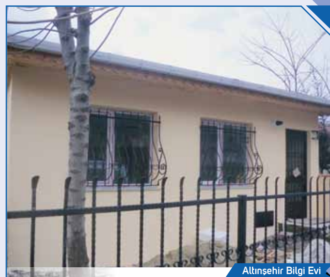
Altınşehir Bilgi Evi
