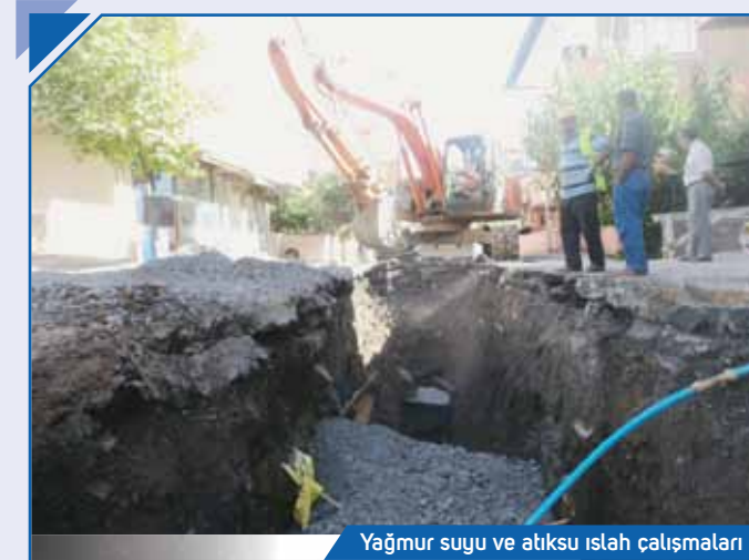
Yağmur suyu ve atıksu ıslah çalışmaları
