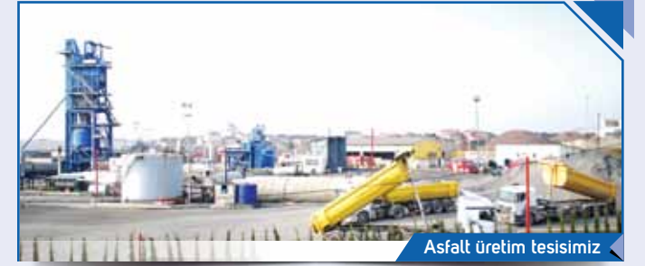
Asfalt üretim tesisimiz
