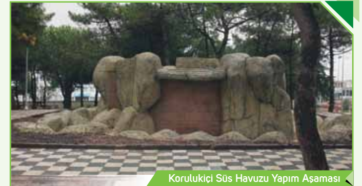
Korulukiçi Süs Havuzu Yapım Aşaması
