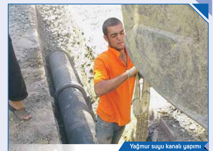
Yağmur suyu kanalı yapımı
