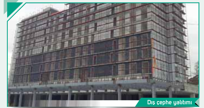
Dış cephe yalıtımı
