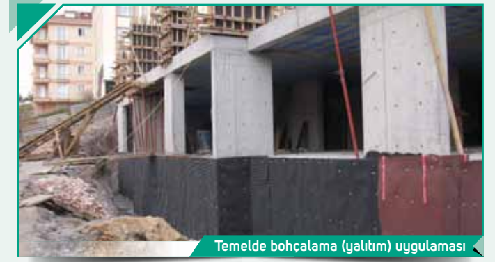
Temelde bohçalama (yalıtım) uygulaması
