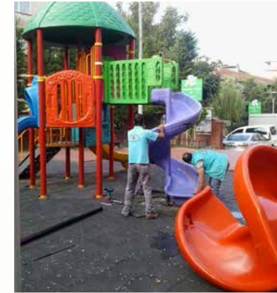
Yeni oyun grubu montajı yapılan yerler
