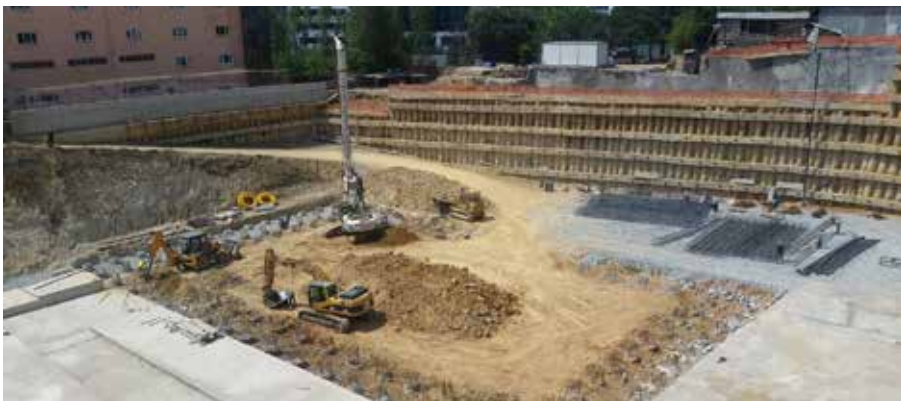
» Temel Altı Kazık ve Fore Kazık Çalışması
