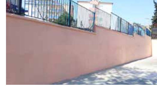
» 30 Ağustos Kız Meslek Lisesi Duvar Yapımı
