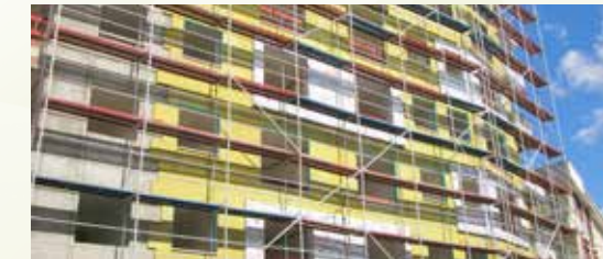
» Dış Cephe Yalıtımı
