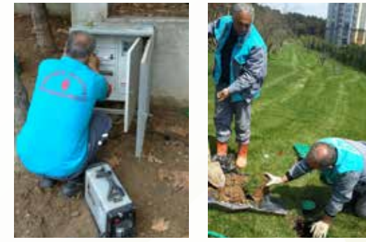
» Elektrik Tesisatı Bakım Onarımı
