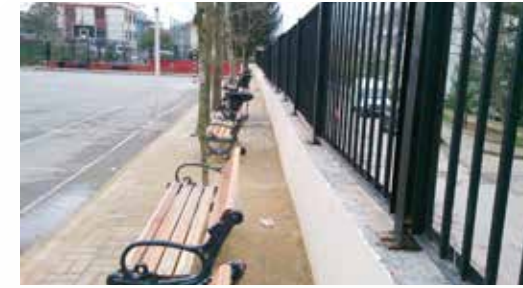
» A.Nihat Asya İlkokulu/Ortaokulu-Duvar,Korkuluk
