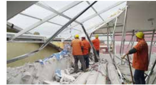
» Ruhsata Aykırı Yapı Yıkımı
