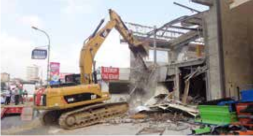
» Ruhsata Aykırı Yapı Yıkımı
