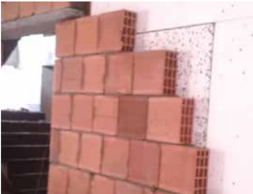
» Ara Duvar Yalıtımı
