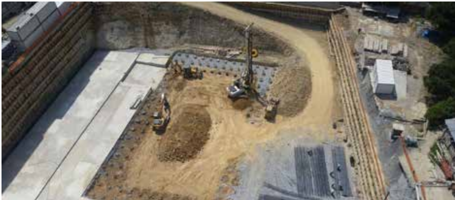
» Temel Altı Kazık ve Fore Kazık Çalışması
