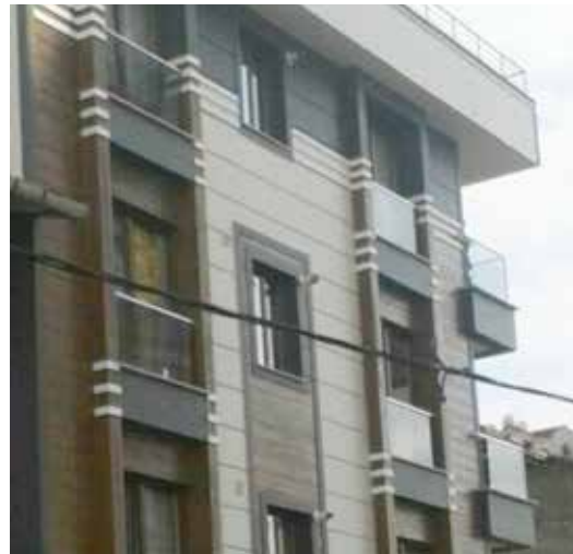
» Kentsel Yenileme Kapsamında Yeni Bina
