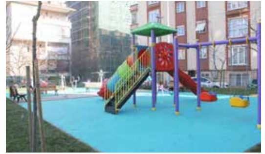
» Aslanağzı Sokak park yapımı
